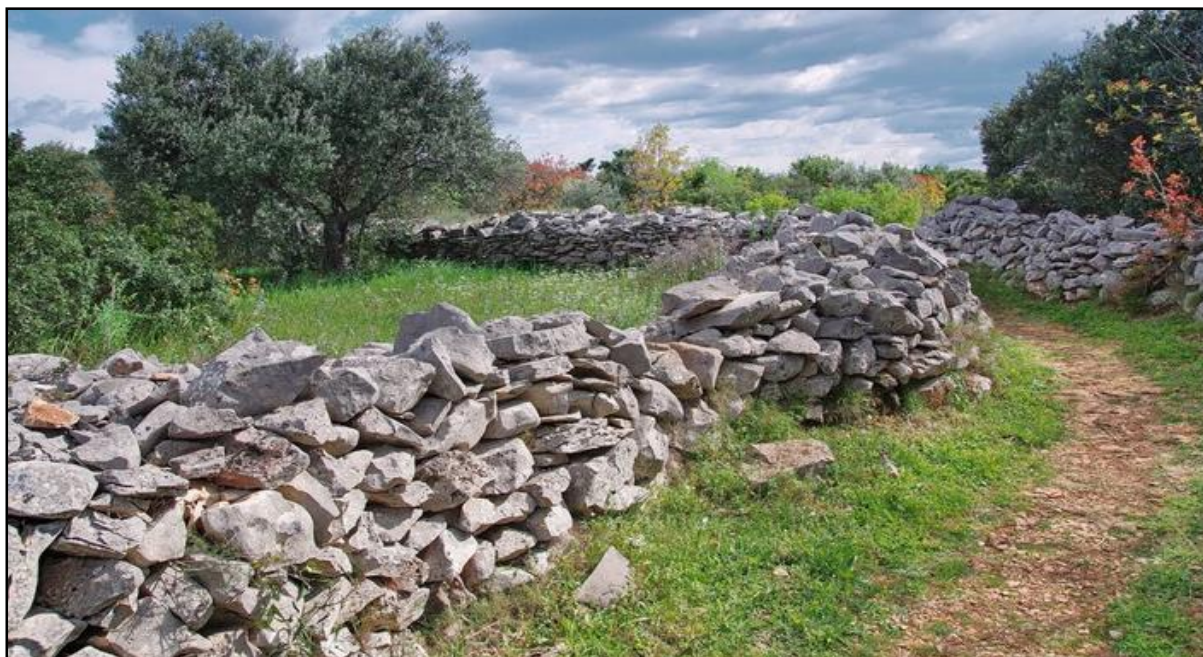
Slika 27. Umijeće suhozidne gradnje
