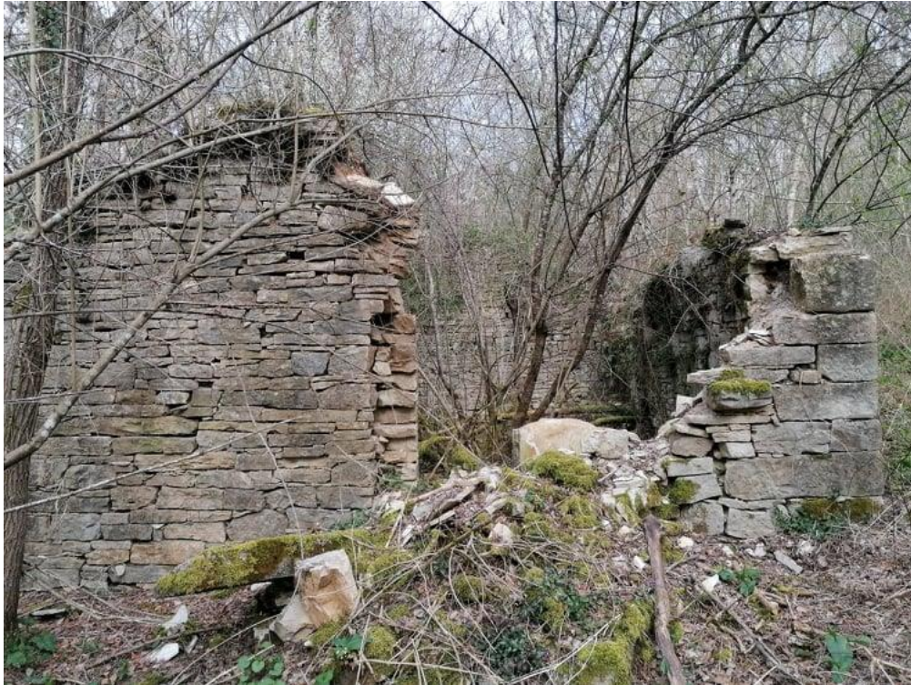
Slika 9. Ostaci malina – ulaz u malin (fotografirala autorica rada)
