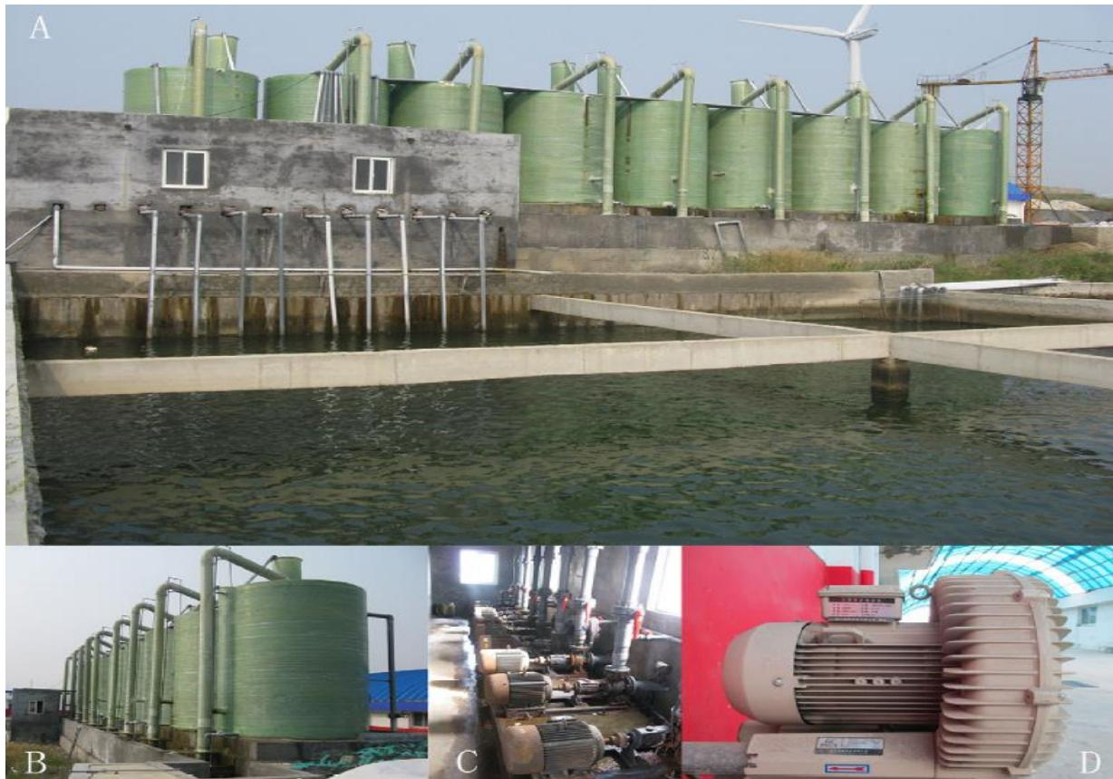
Slika 9. Tipični filtracijski sustavi i pumpe koji se koriste za uzgoj *A. japonicus*. (A) Taložnica (sprijeda) i pješčani filtri (straga) za izdvajanje suspendiranih čestica iz vode. Vjetrogeneratori se sve češće koriste za dobivanje električne energije u objektima za akvakulturu *A. japonicus*. (B) Pješčani filter za mehaničku filtraciju. (C) Unutarnja pumpa za recirkulaciju vode u sustavu (D) Zračne pumpa (Izvor: A,B,C - Shilin Liu, 2015; slika D: Yucen Bai, 2015).
