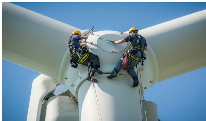
Slika 6. Prikaz održavanja vjetroelektrane
