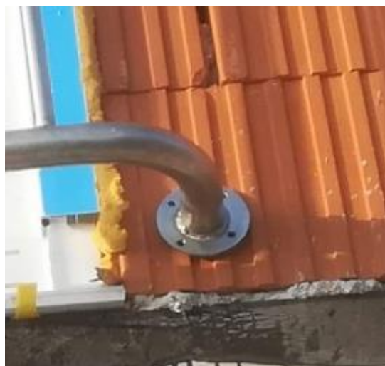
Slika 27. Zavarena cijev za pločicu
