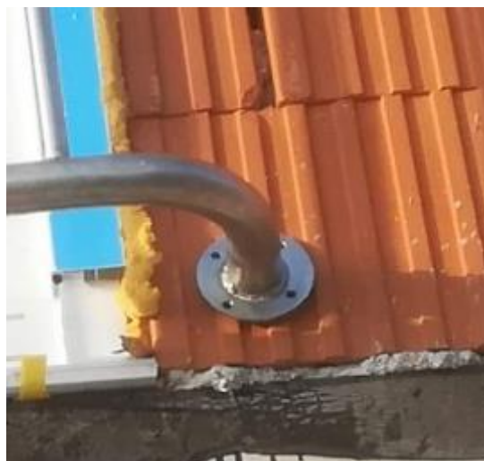
Slika 27. Zavarena cijev za pločicu
