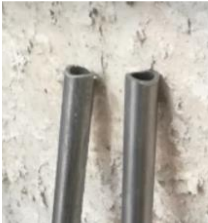
Slika 19. Ogranak (branket) nazivnog promjera d=21.3 mm
