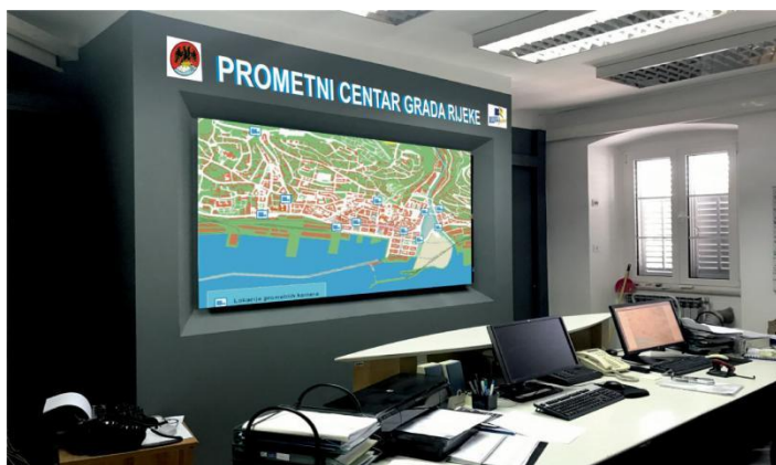
Slika 16. Sustav automatskog upravljanja prometom
