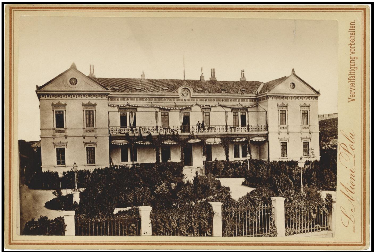
Fotografija 2: Stara zgrada Marine kasina
