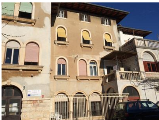
Slika 12: Zgrada Gerontološkog centra Vila Trapp Izvor: autor
