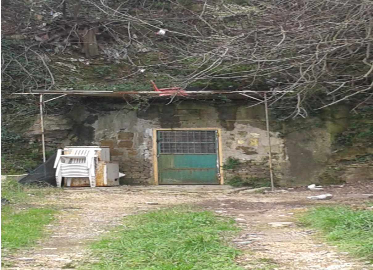
Slika 5. Ulaz u tunel br. 19 (Izvor: autor)
