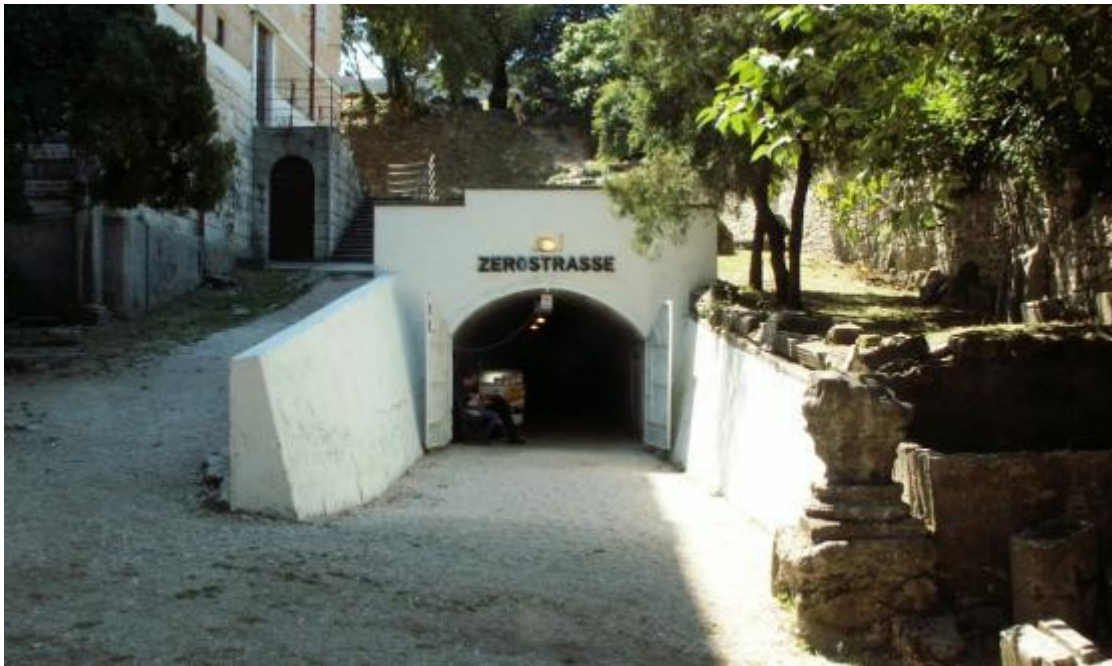
Slika 1. Ulaz u tunel Zerrostrasse (Izvor: http://www.istarski.hr/node/3785 , 12. 05. 2015.)
