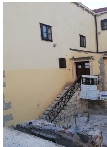
4d. Mjesto buduće dogradnje GMS
