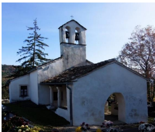
Sl. 13. Crkva Svih Svetih, Gradinja
