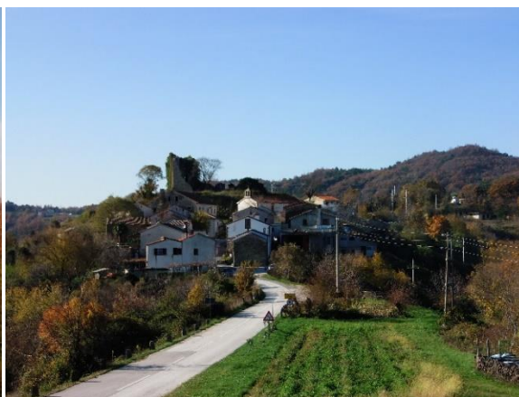
Sl. 31. Pogled na Paz i kaštel
