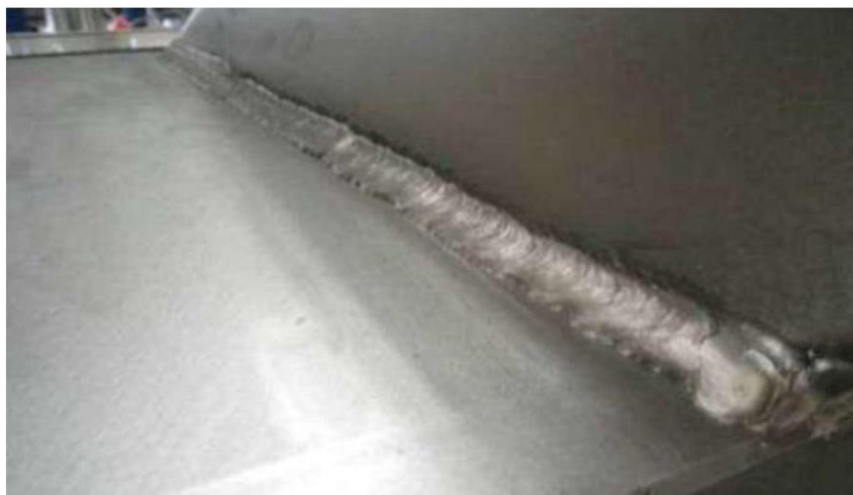
Slika 14. Primjer ugorina po cijeloj dužini zavara
