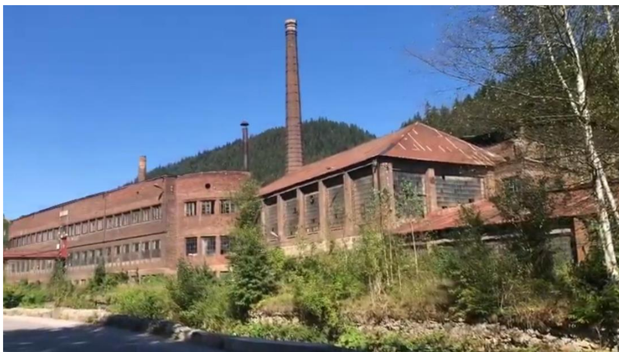
Slika 8. Zapuštena infrastruktura Željezare Vareš
