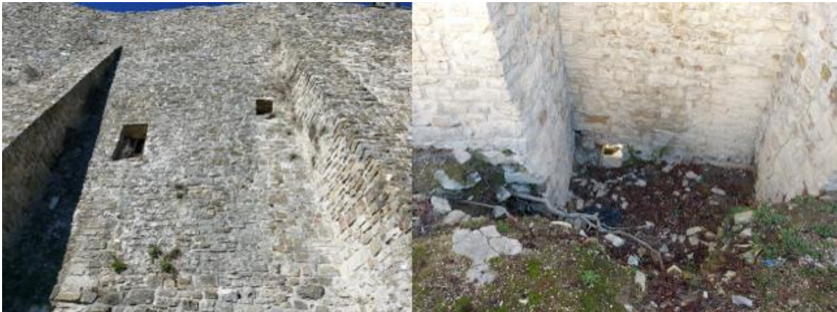
Slika 7 Puškarnica i odvod iznad barbacana (Autor: Michele Benčić)
