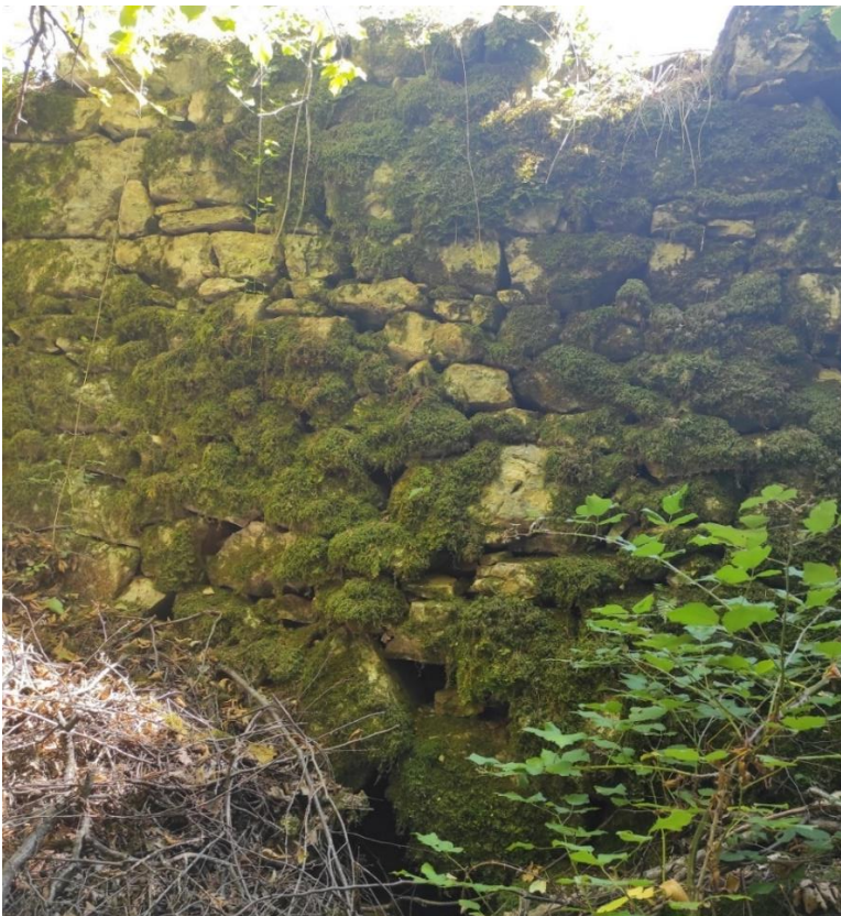
Slika 10. Potporni zid ceste u Potòku Sekie, koja spaja Mošćenice i Svetu Jelenu. Snimio: Marko Blaženić, 2021.
