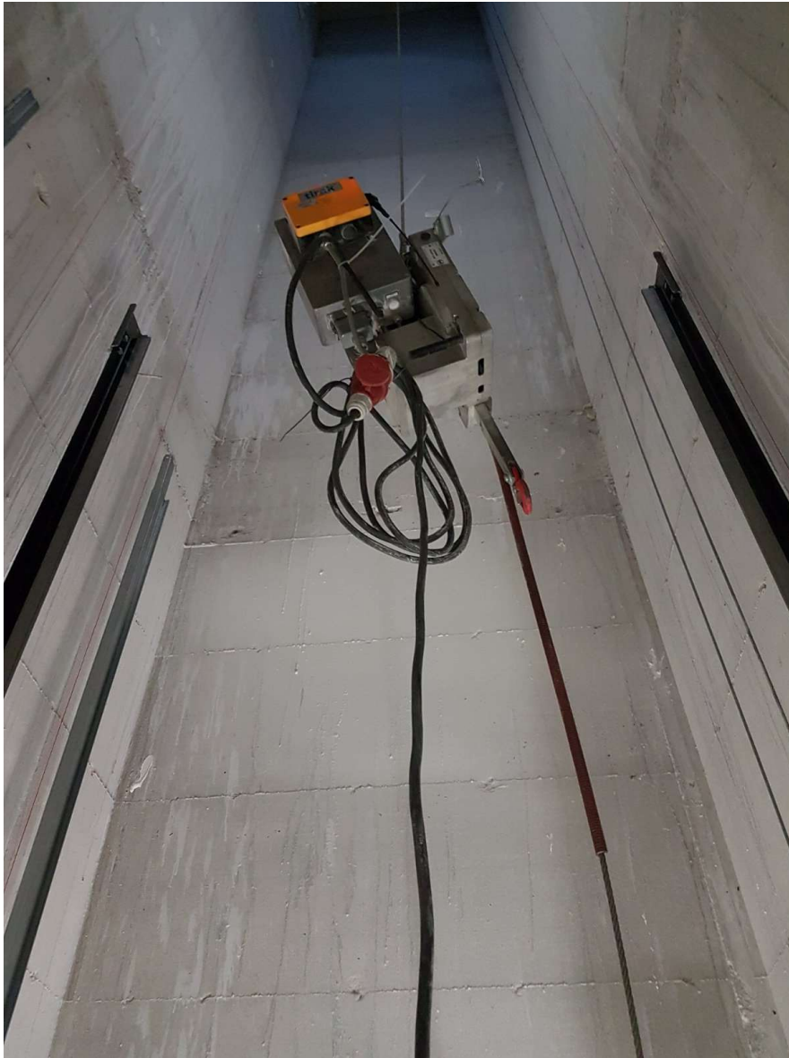
Slika 20. Električni vinč ovješena za kuku
