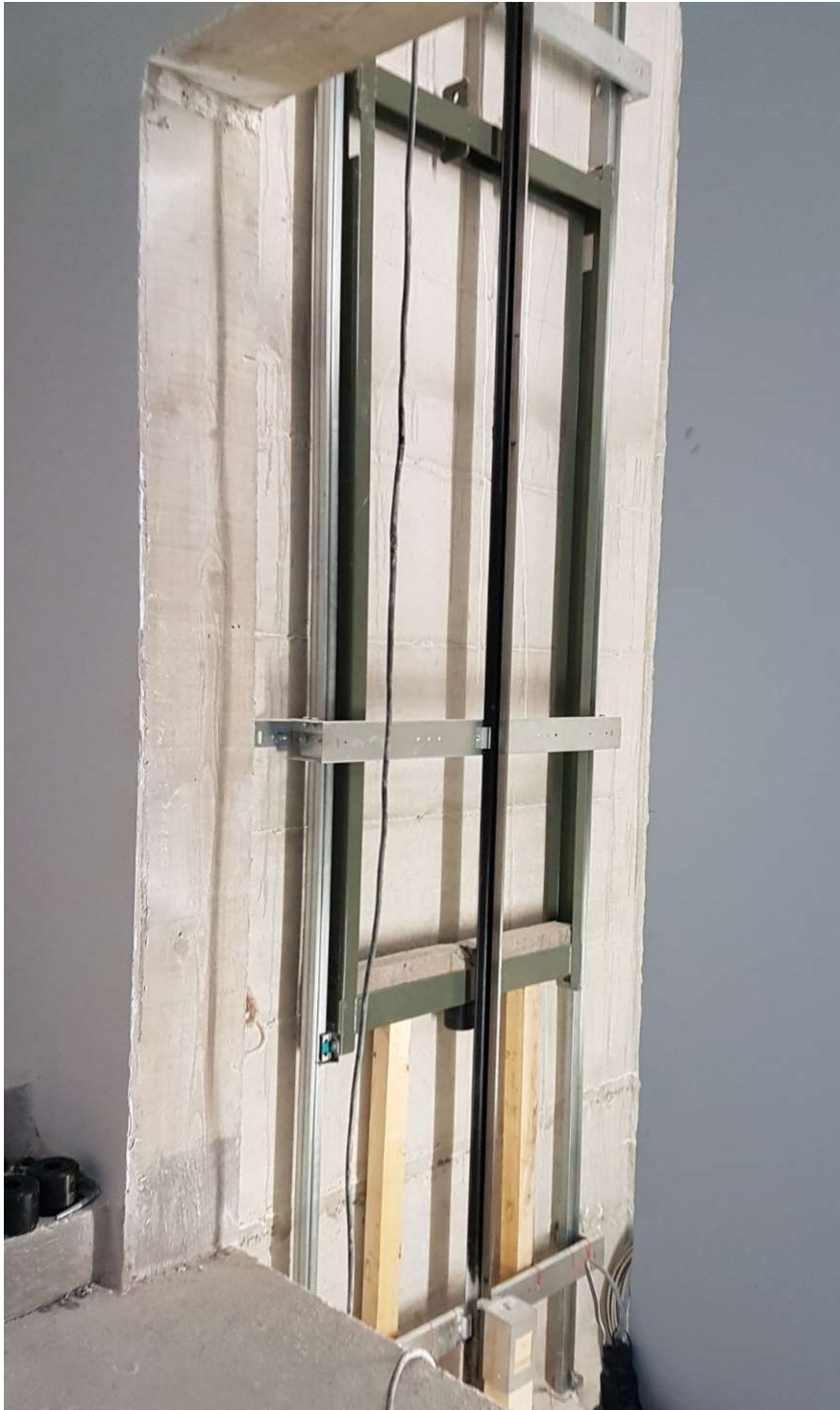
Slika 22. Okvir protuutega
