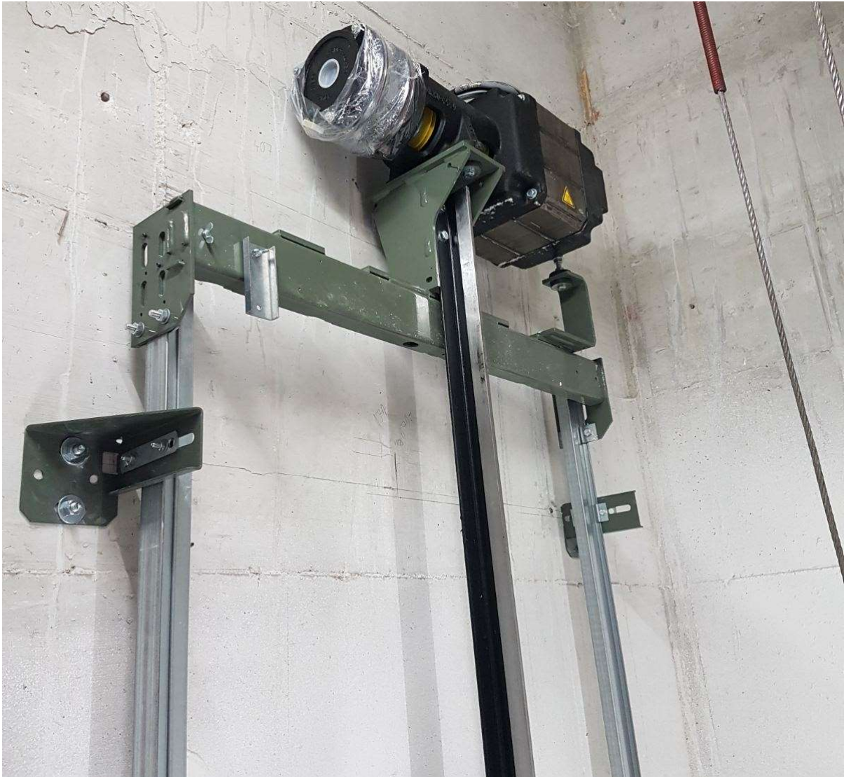
Slika 24. Pogonski motor na nosaču
