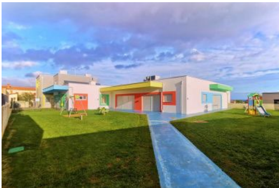
Immagine n.14 L'edificio della scuola dell'infanzia "Coccinelle" di Lisignano ( https://www.dvbubamara.hr/ )
