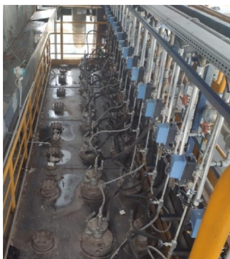
Slika 51. Tlačni sustav dušične vode [11]
