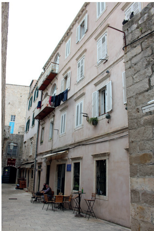
Slika 1. Zgrada u ulici kneza Damjana Jude u kojoj se sve do nakon Prvog svjetskog rata nalazila javna kuća. Danas je tu Klub pomoraca „Miho Pracat“.
