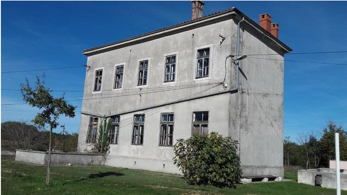
Slika 4: Zgrada stare škole u Šajinima (stanje prije provedbe projekta)
