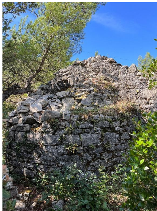
Slika 48. Vanjski izgled apside Snimila: Višnjčić, 2023.
