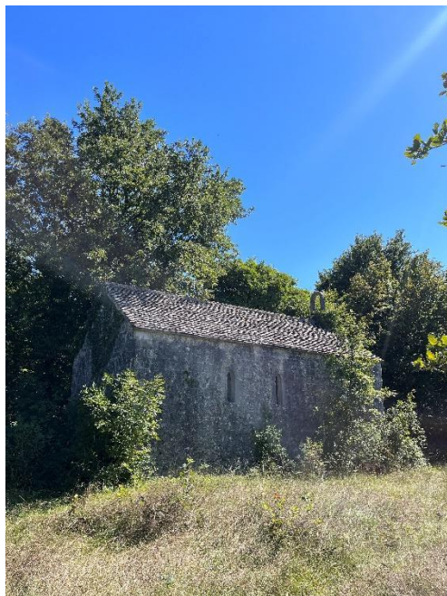
Slika 55. Vanjski izgled kapele
