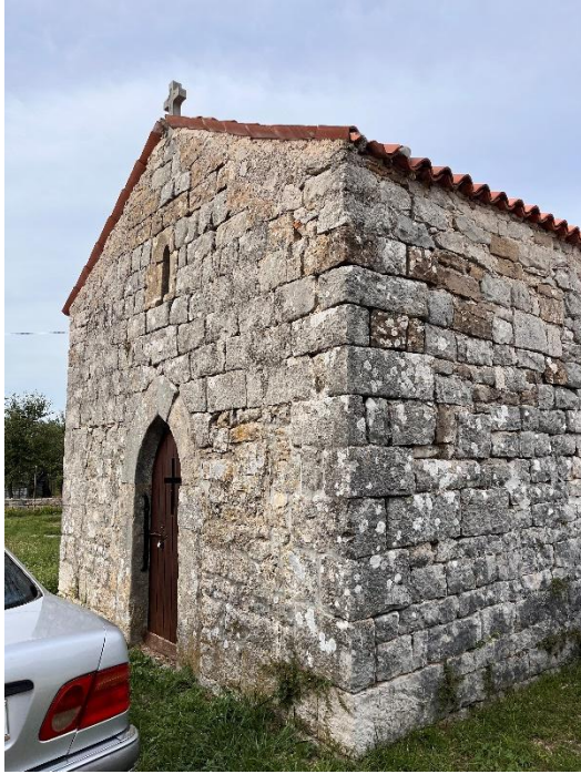
Slika 58. Vanjski izgled kapele s pročeljem
