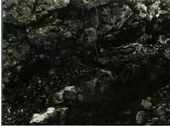
Slika 7. Gradinski zidovi – glavni ulaz, Fn. 5501
