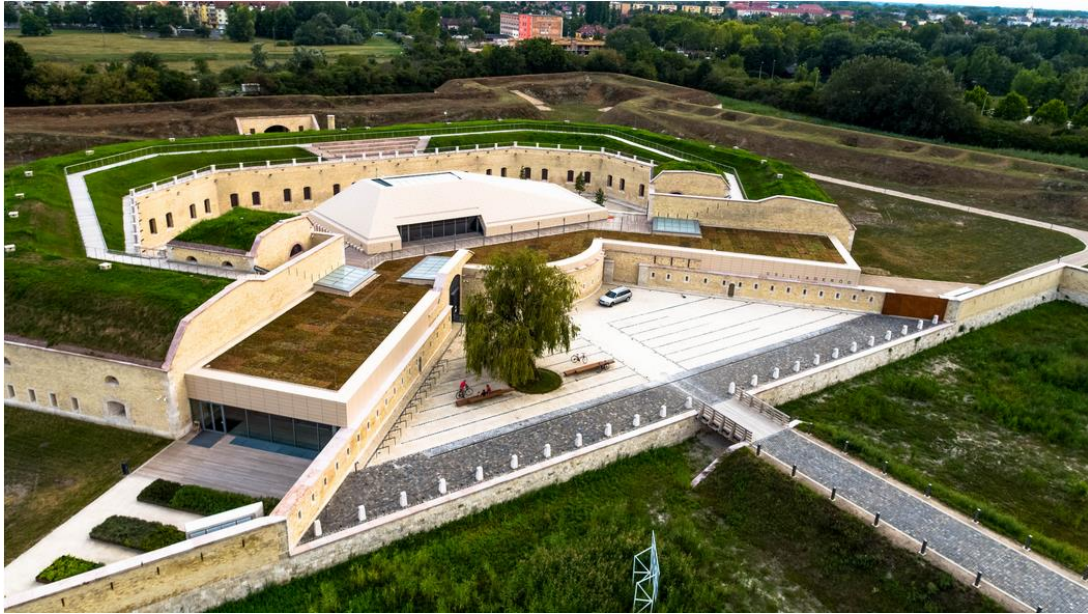
Slika 2. Utvrda Csillag nakon renovacije (Izvor: ligetbudapest.hu)
