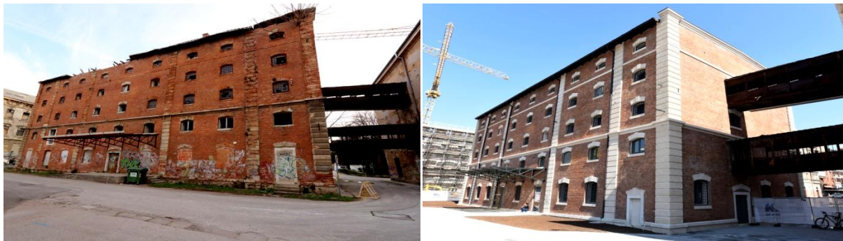
Slika 5. Dječja kuća prije obnove (lijevo) i Dječja kuća nakon obnove (desno)
