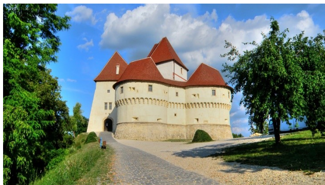
Slika 11. Veliki Tabor nakon obnove
