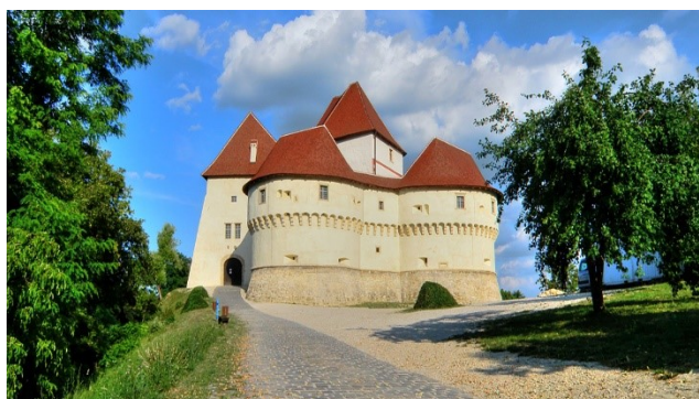
Slika 11. Veliki Tabor nakon obnove
