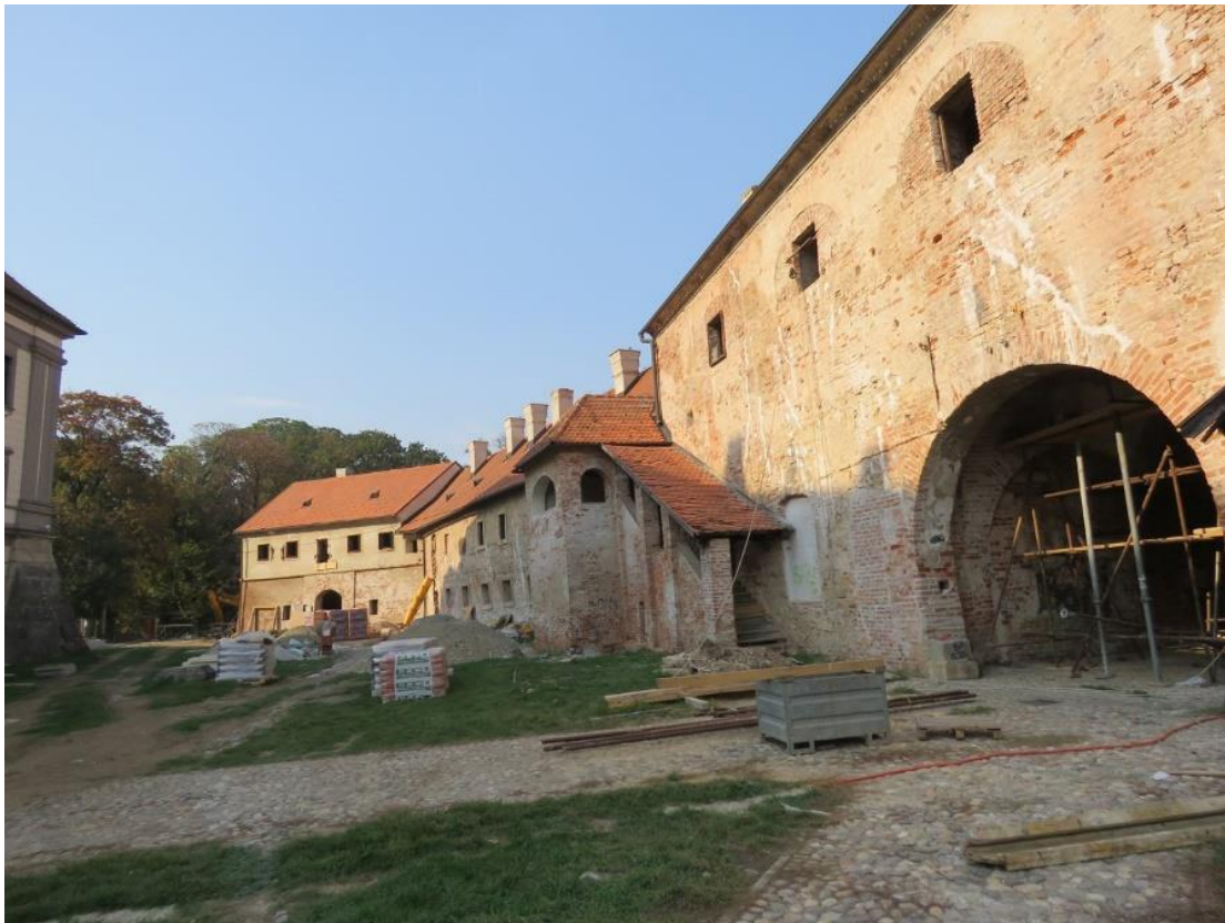
Slika 12. Zgrade prostora muzeja Riznica Međimurja tijekom renovacije
