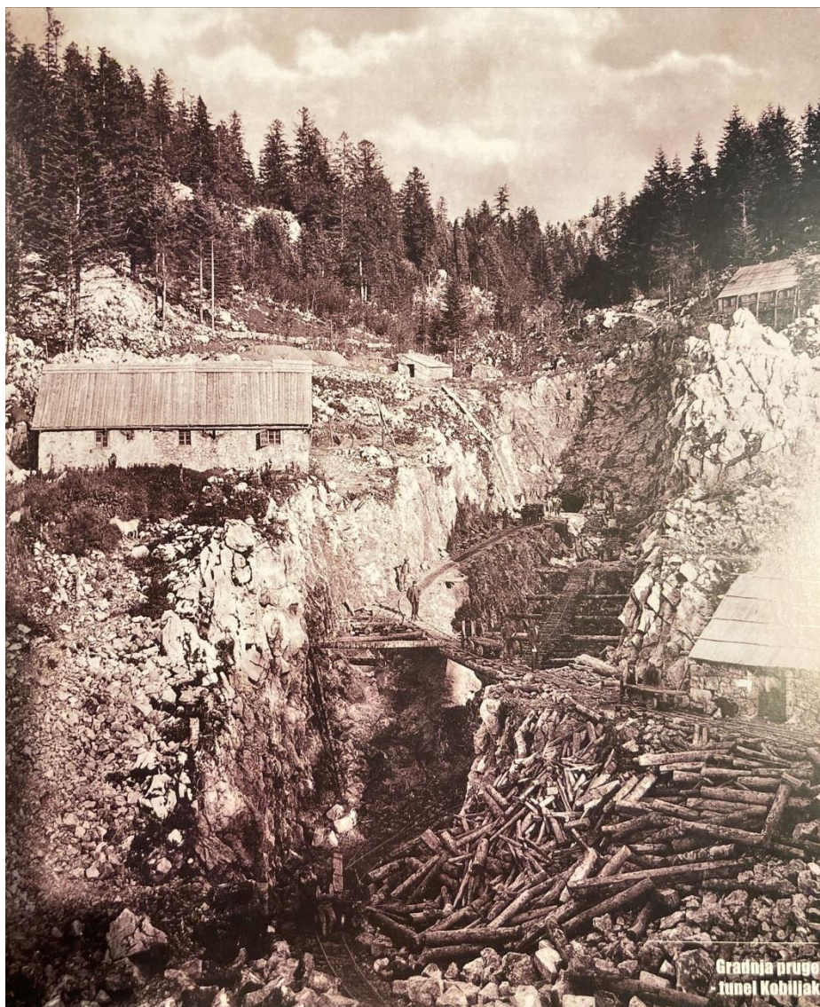
Slika 8: Izgradnja željeznice kod tunela Kobiljak 136
