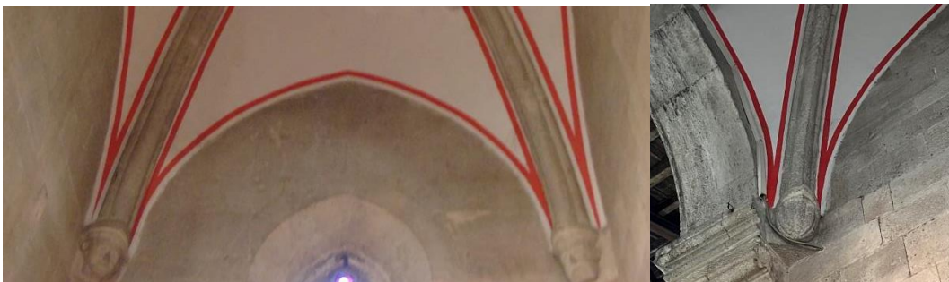
Slika 13. Crkva sv. Franje - konzole rebara svoda
