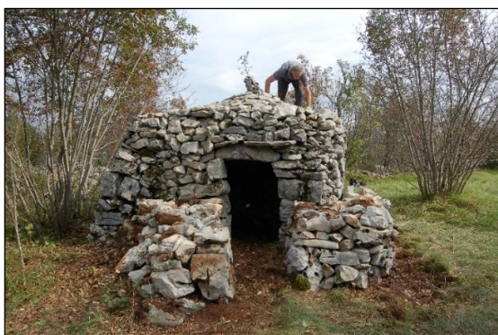
Slika 7. Primjer suhozidne gradnje u Sloveniji
