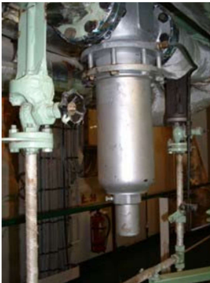
Slika 9. Ventil za kontrolu tlaka (Vlačić, 2006)
