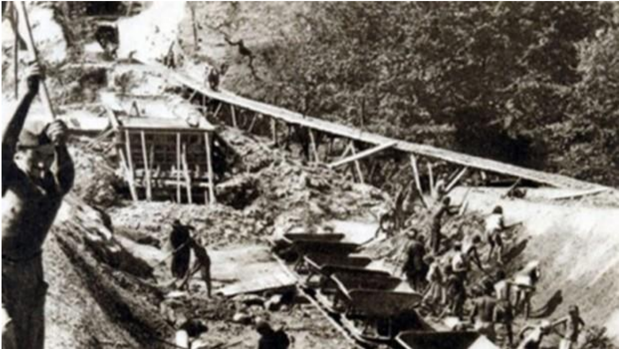
Slika 8: Izgradnja pruge Brčko - Banovići, 1948.
