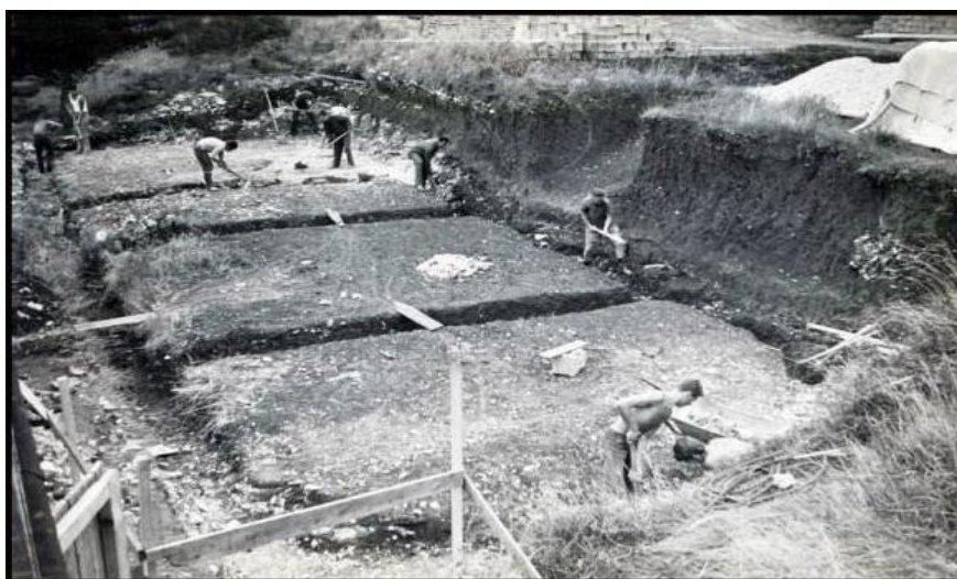
Slika 3. Priprema temelja za zgradu. Volonteri s učiteljem Adlešičem
