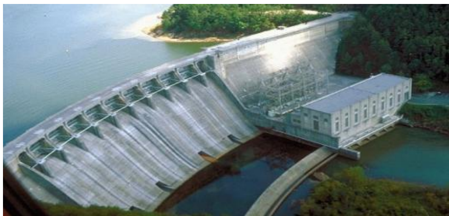
Slika 4. Hidroelektrana u Hrvatskoj ( Izvor : http://www.lolhr.com/blogovi/energetika/39-hidroelektrane-u-hrvatskoj.html , 2016.)
