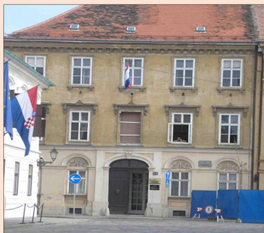
Slika 2. Zgrada na Trgu sv. Marka nekadašnjeg MVP-a
