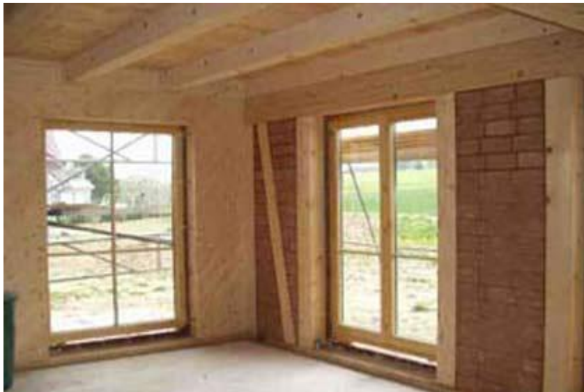
Slika 29: Žbukanje zidova ilovačom
