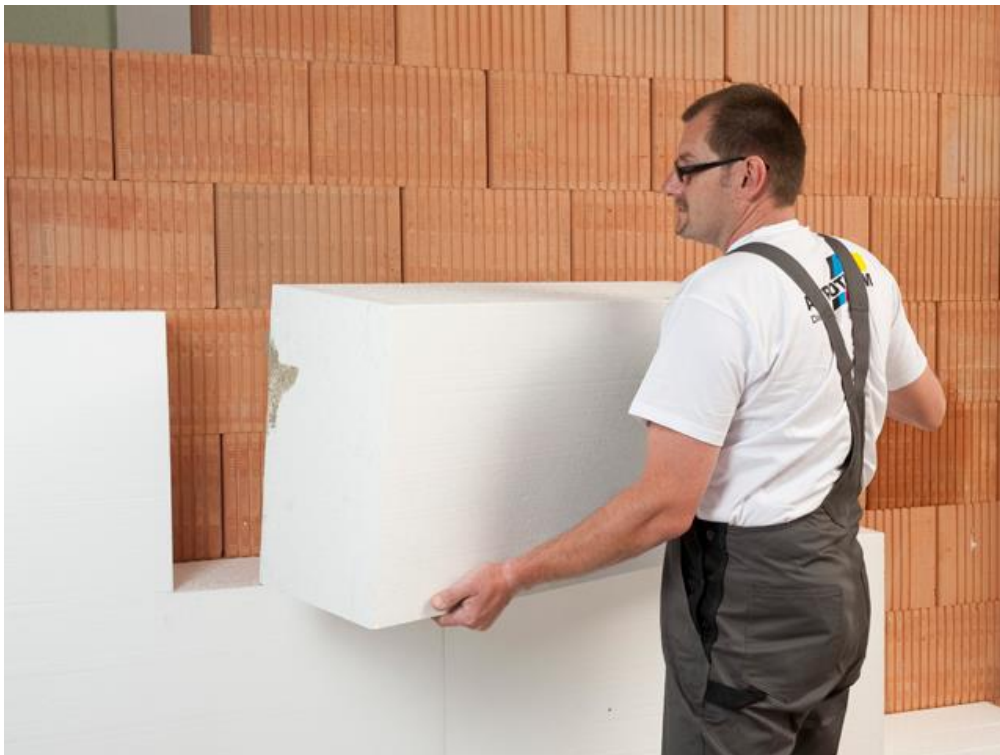
Slika 24: Izolacija kuće ekspandiranim polistirenom
