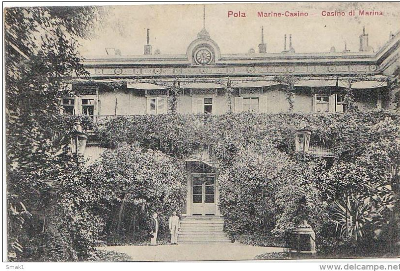
Slika 21., Prva građevina Marine Kasina. Stara zgrada je kasnije srušena i na njenom mjestu je 1913. sagrađeno novo, veće zdanje.
