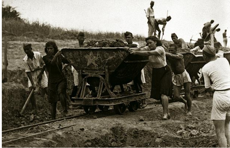
Sl. 6, brigadiri u akciji izgradnje prve omladinske pruge.
