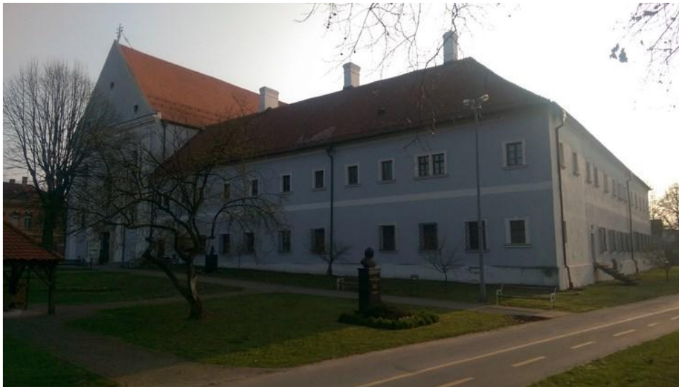
Sl. 6. Franjevačka crkva Presvetog Trojstva sa samostanom
