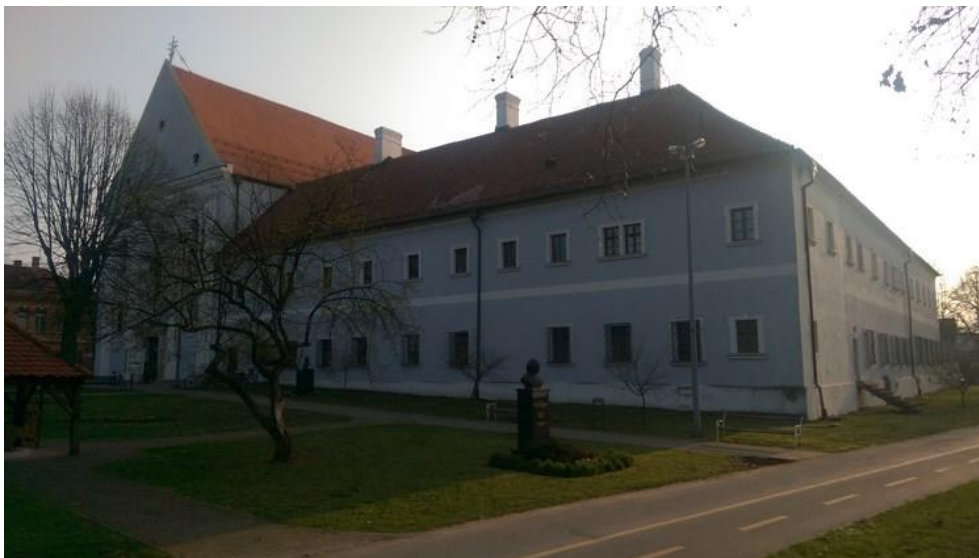
Sl. 6. Franjevačka crkva Presvetog Trojstva sa samostanom
