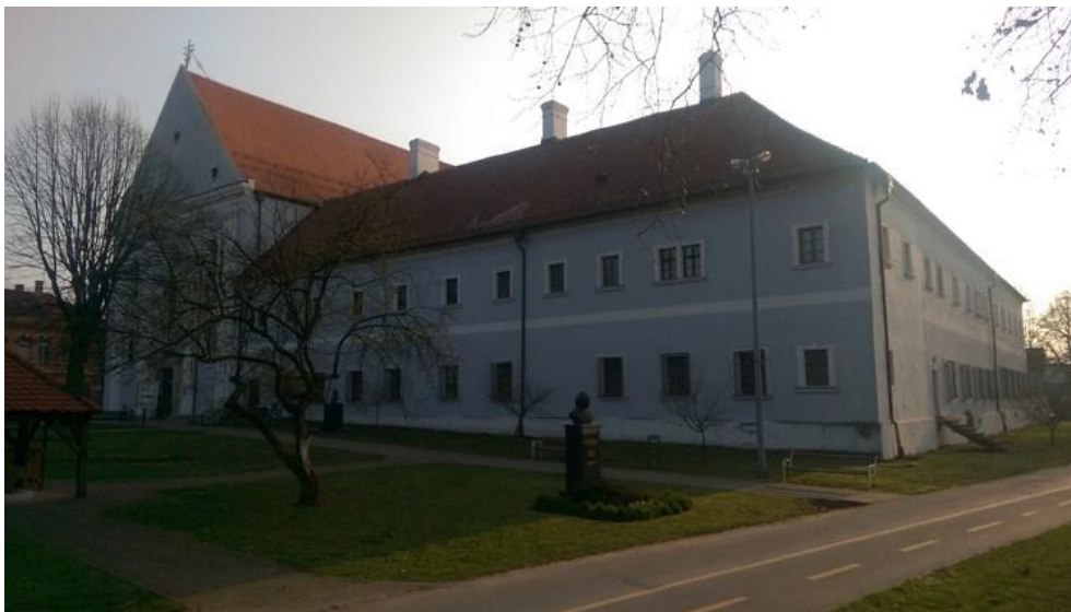
Sl. 6. Franjevačka crkva Presvetog Trojstva sa samostanom
