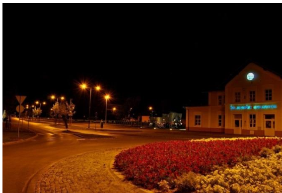
Slika 8. Zgrada željezničkog kolodvora
