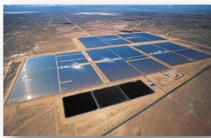
Slika 3: Parabolična protočna TE 30 MWe, Kramer Junction, California
