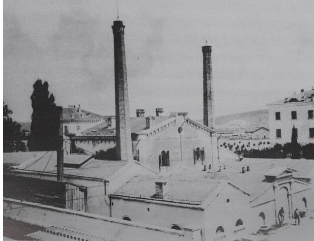
Slika 12: Zgrada vojnog vodovoda na Karolini 1861. (Krizmanić, 2005., str. 149.)
