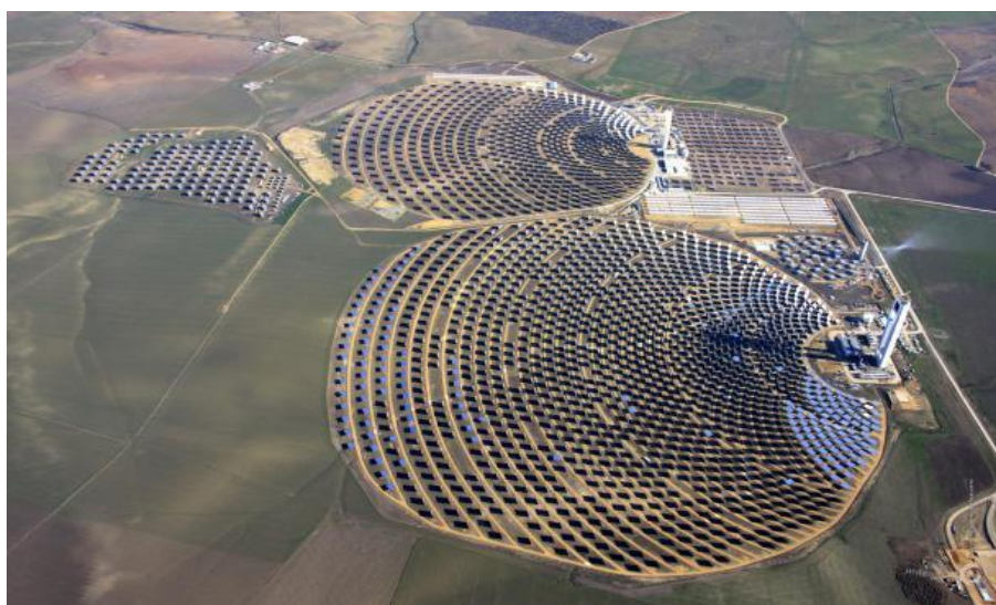
Slika 2. Solarni toranj konfiguracija zrcala fokusira Sunčevu energiju prema vrhu tornja
