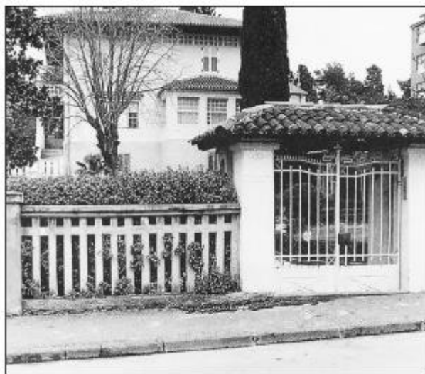
Vila Riedlein u Bazovičkoj 20, ulaz
