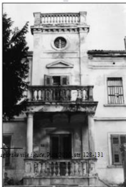
Vila Rizzi, pročelje
