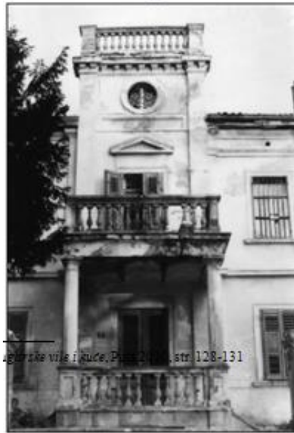
Vila Rizzi, pročelje
