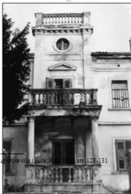
Vila Rizzi, pročelje
