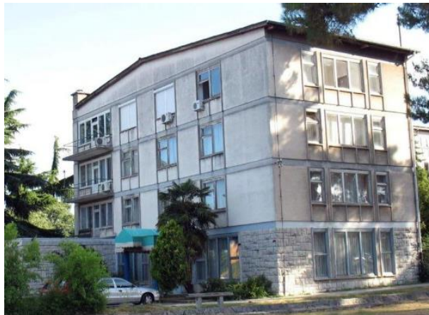
Slika 2. Ruševna zgrada u Labinu
