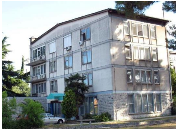
Slika 2. Ruševna zgrada u Labinu
