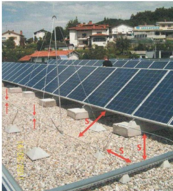
**Slika 8 Primjer izoliranog sustava gromobranske zaštite**
