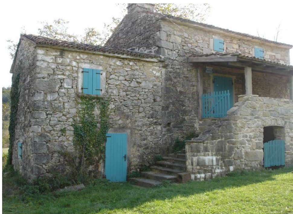
Slika 12: Istarska kuća s baladurom
