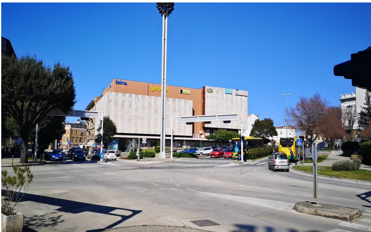
Slika 11. Robna kuća Pula
