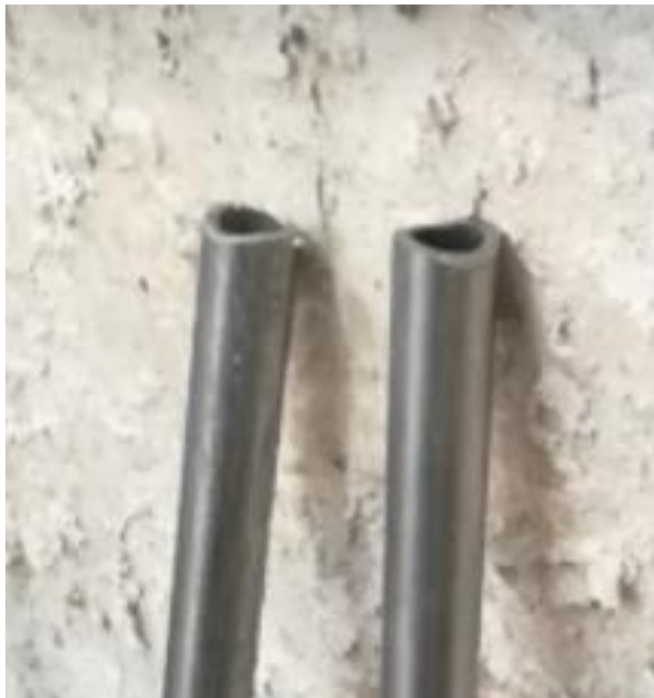
Slika 19. Ogranak (branket) nazivnog promjera d=21.3 mm
