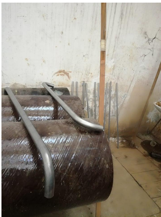
Slika 16. Cijevi nakon faze rezanja i savijanja, 2.
